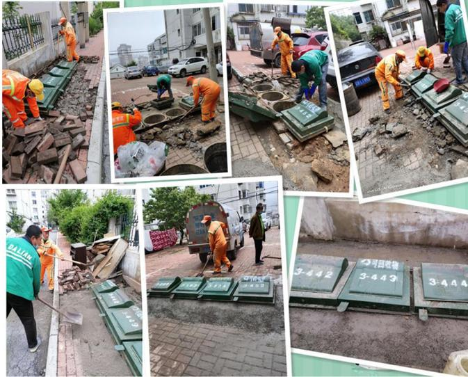
♥️ 5月22日下午，中韦巷地埋桶因下雨和耗子盗洞导致周边地面塌陷下沉，造成损坏。我公司立即组织维修人员对其进行了彻底的修复。瞧我们的环卫工人，砌砖、
