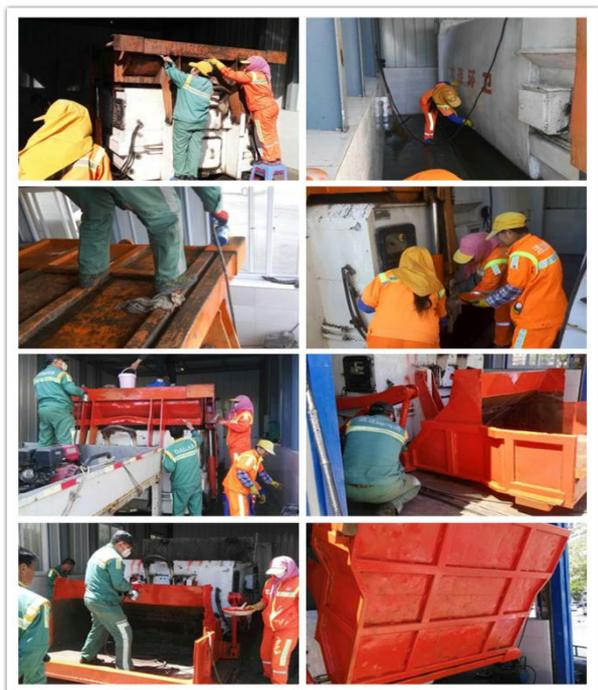
左图为5月14日三八所工人对大罐进行除臭、清洗、除锈、刷漆等工作：场面热火朝天。
