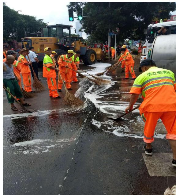
休息时间，头顶骄阳，脚踩油污，手持铁锹，挥锹撒土，一段一段地向前清理，全力清扫洒漏原油及被污染道路、人行道等。覆盖沙土后反复清扫，充分吸沾原油。现场整个清扫过程井然有序，大家身上也都沾满了油污，为确保交通晚高峰到来尽最大努力争分夺秒抢时间，不顾疲劳，完成应急作业任务。
